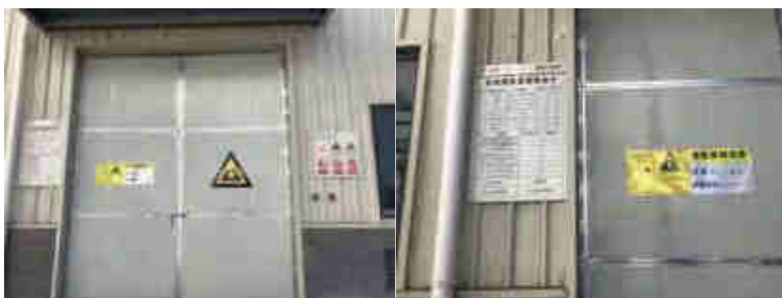
神华罗源湾电厂危险废物暂存库
