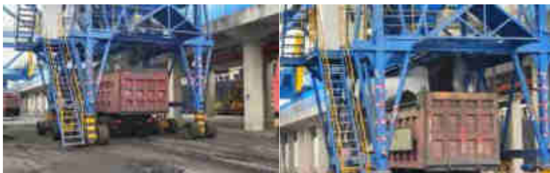
接料斗上防风围挡和喷水抑尘装置
