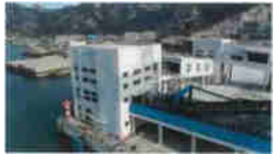
转运站封闭转接机房
