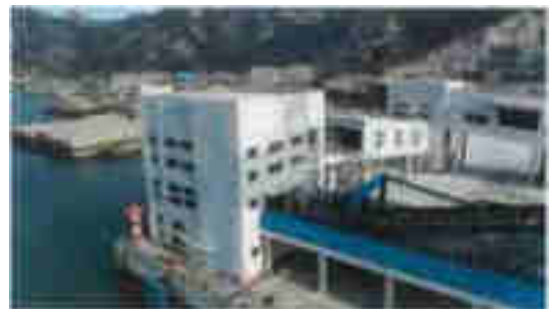
转运站封闭交接机房
